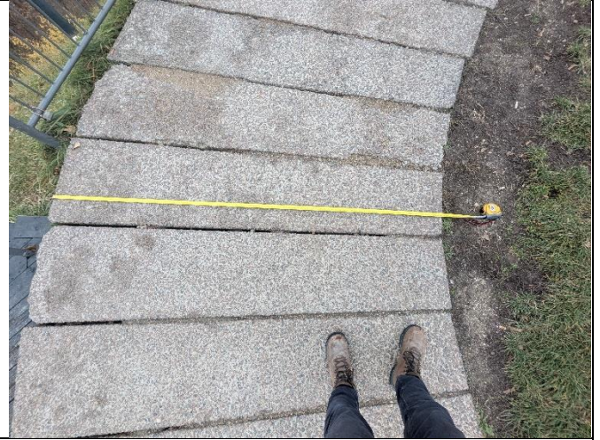
4 pav. Išmatuotas Trijų kryžių paminklo apžvalginės aikštelės plokštės ilgis.
