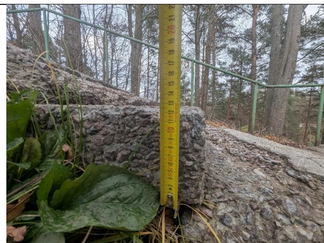
15 pav. Išmatuotas Trijų kryžių paminklo laiptų plokštės aukštis.
