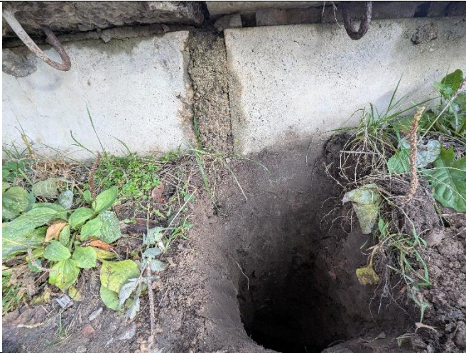
9 pav. Atkastas Trijų kryžių paminklo apžvalginės aikštelės pamato šūrfas.
