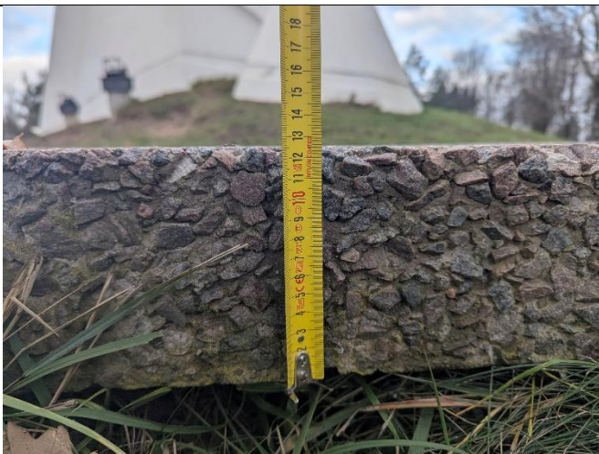
7 pav. Išmatuotas Trijų kryžių paminklo apžvalginės aikštelės plokštės aukštis.
